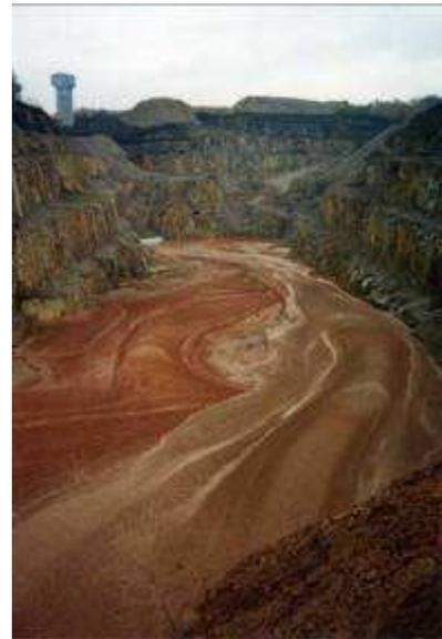
12 et 13 Déversement de résidus de l'usine SIMO de Bessines dans la carrière COGEMA de Bellezane en Limousin (CRIIRAD, 1993)
